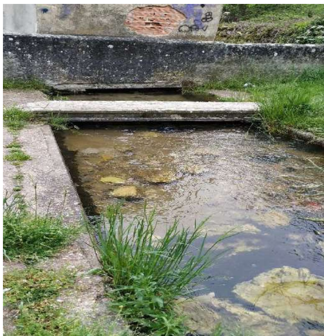
FUENTE DE LA FRAGUA. PRÁDENA (F-1)
