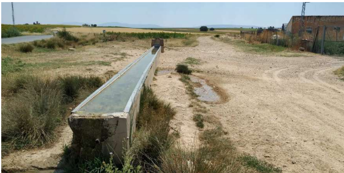
EL PILÓN. REBOLLAR (F-48)
