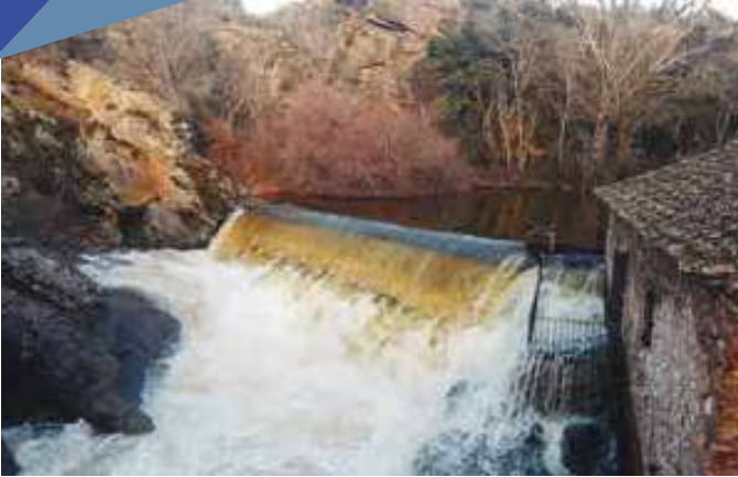
Azud y molino de la Cubeta, en el río Cega en las proximidades de La Velilla.
