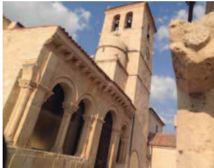
Magnífica cantería en piedra caliza en la iglesia de Bernuy de Porreros
