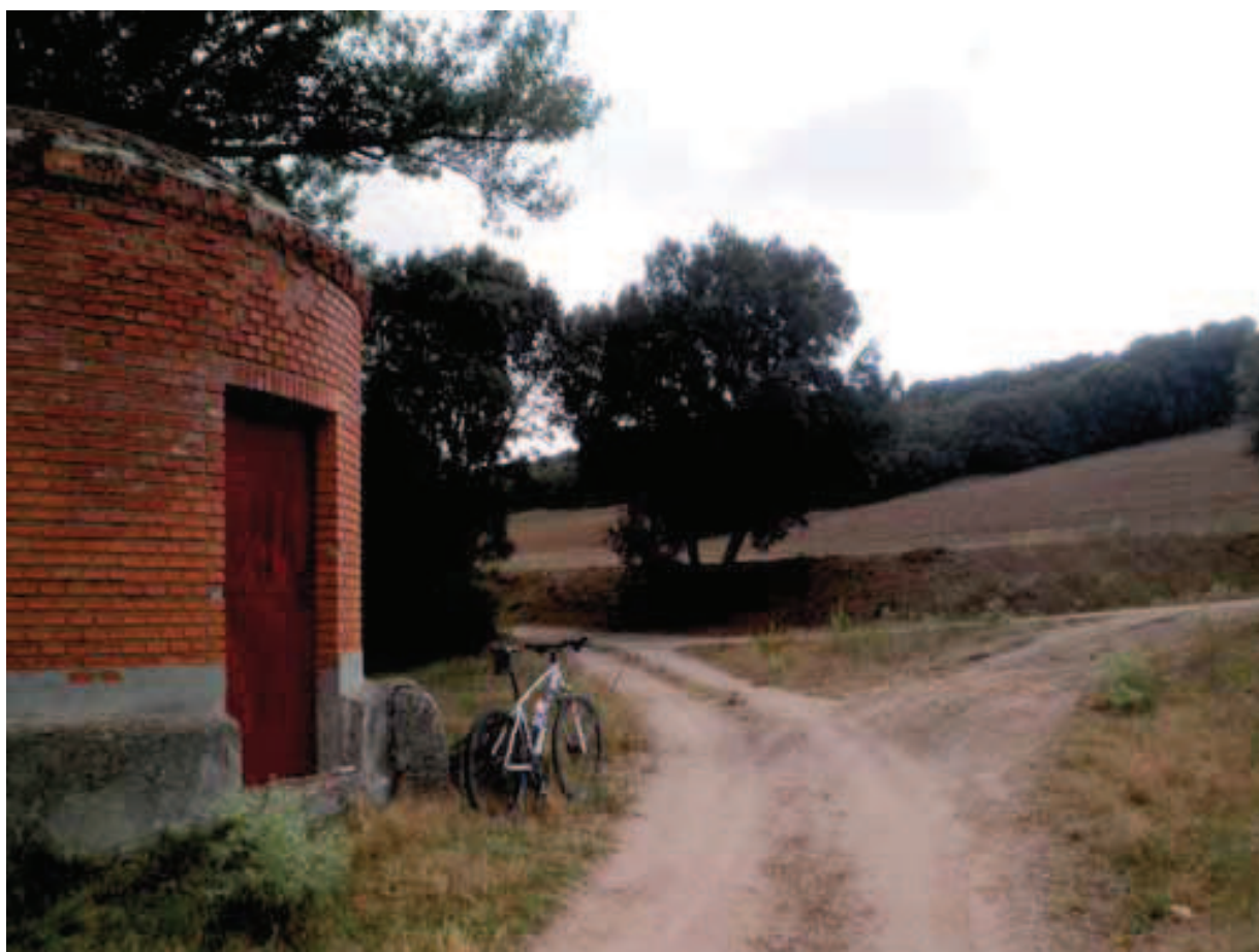
Depósito de agua junto al río Piezga en Lastras del Pozo
